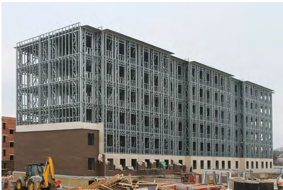
возведение каркаса
