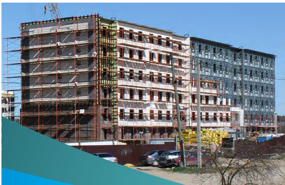
монтаж несъемной опалубки
