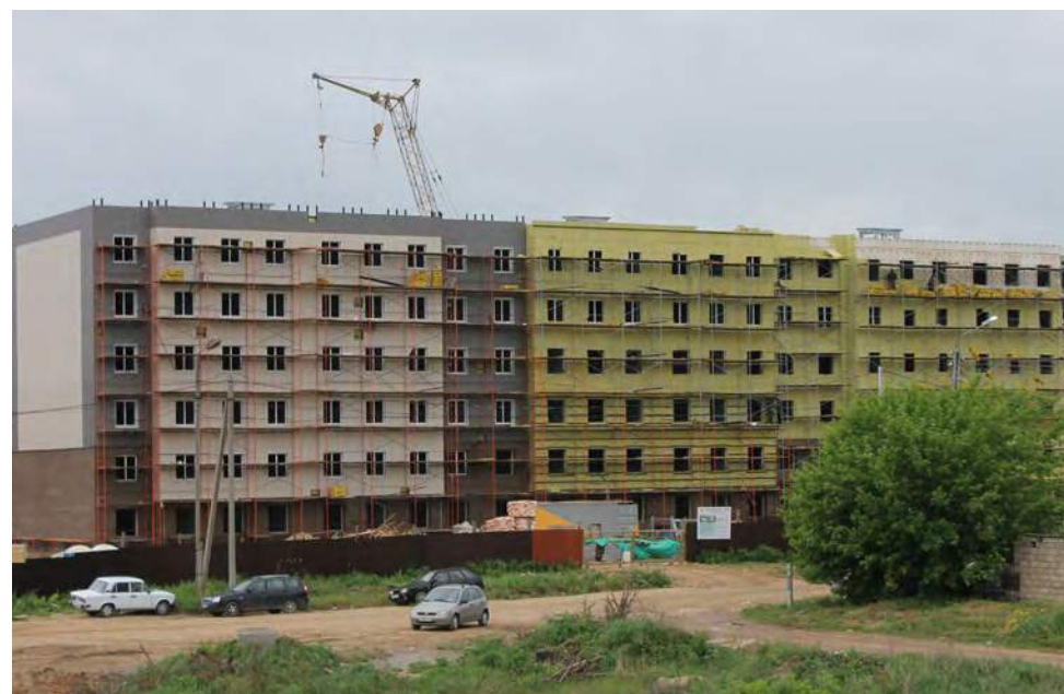
теплоизоляция здания: внутренняя – пенобетон, наружная – минвата
