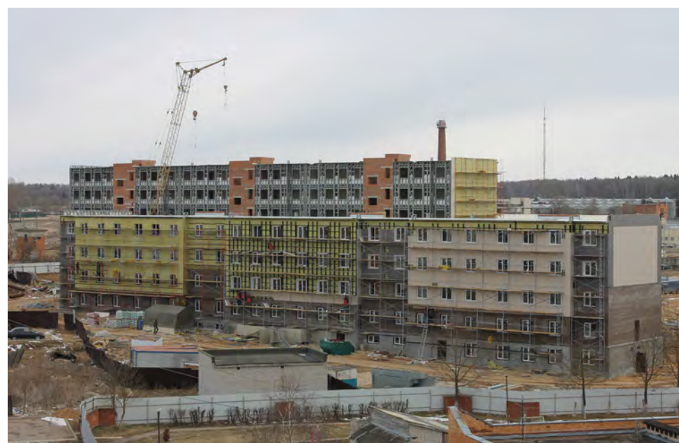
теплоизоляция здания: внутренняя – пенобетон, наружная - минвата
