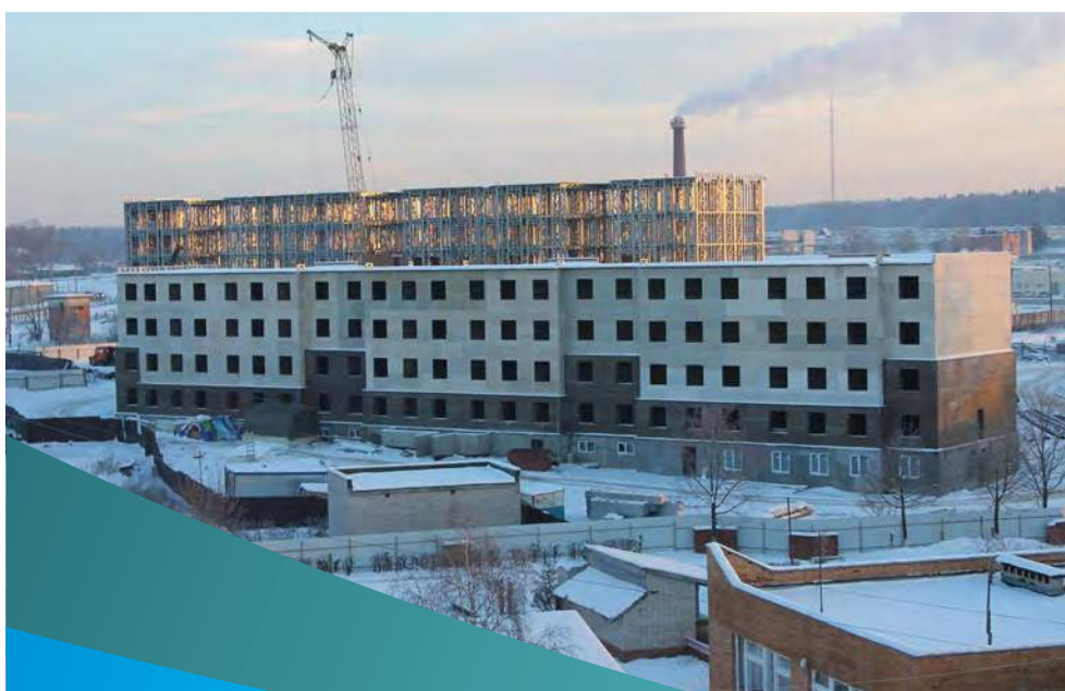
монтаж несъемной опалубки
