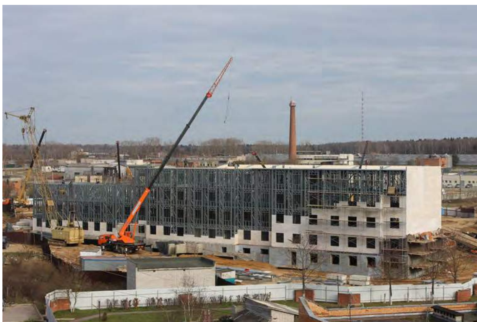
возведение каркаса
