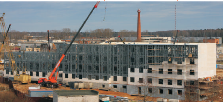
Этапы строительства 4-этажного трехсекционного
