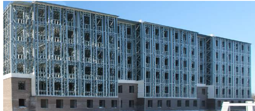
Жилые и общественные здания на оцинкованных каркасах (серия СТИЛТАУН®)
