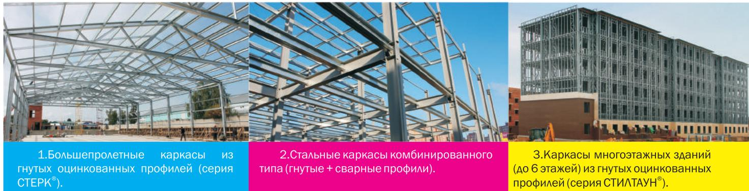
1. Большепролетные каркасы из гнутых оцинкованных профилей (серия СТЕРК®).
