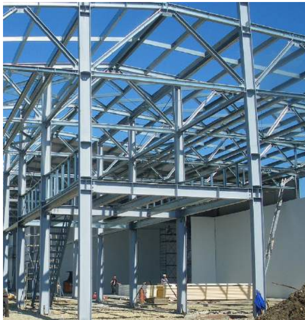
Вариант 1: балки перекрытия - из двутавров
