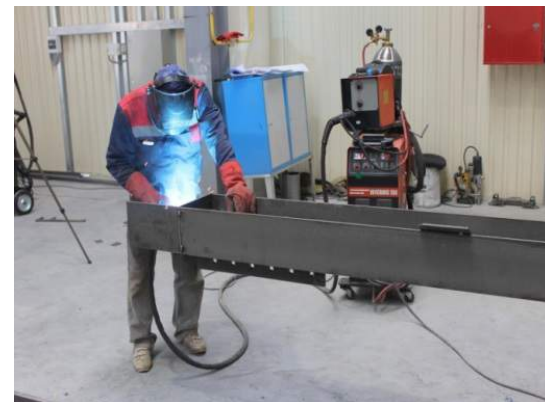
Посты полуавтоматической сварки деталей
