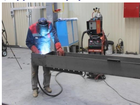
Посты полуавтоматической сварка деталей
